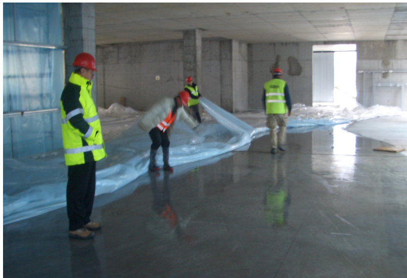
Foto 2. Massetto flottante si soli 8-9 cm, stagionato per 4 settimane con copertura con teli di polietilene. Planarità media rilevata 1,2 mm anche a callo dei giunti di costruzione [ Ospedale Hos.AL.VI. Thiene]
