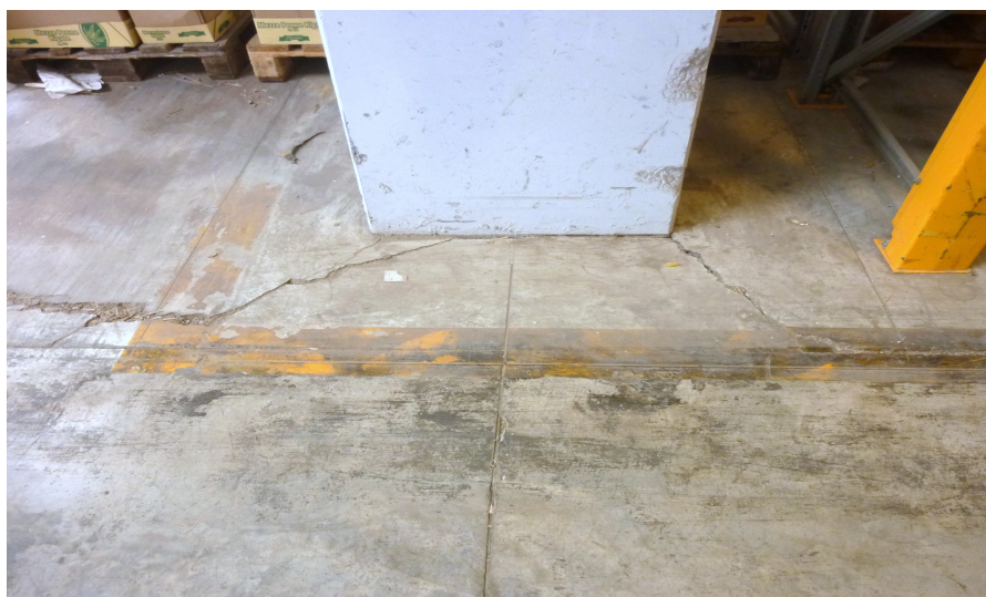
Foto 8. Fessure da spigoli di pilastro per insufficiente isolamento perimetrale e mancato inserimento di barre a 45° negli spigoli
