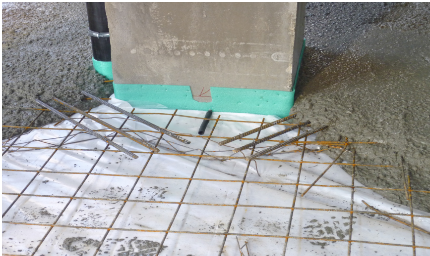
Foto 9. Esempio di prevenzione di fessure dagli spigoli di pilastri
