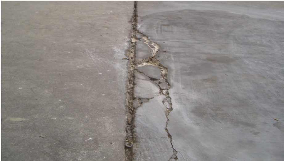
Foto 11. Frantumazione del giunto di costruzione causato dall'impatto delle ruote dei carrelli
