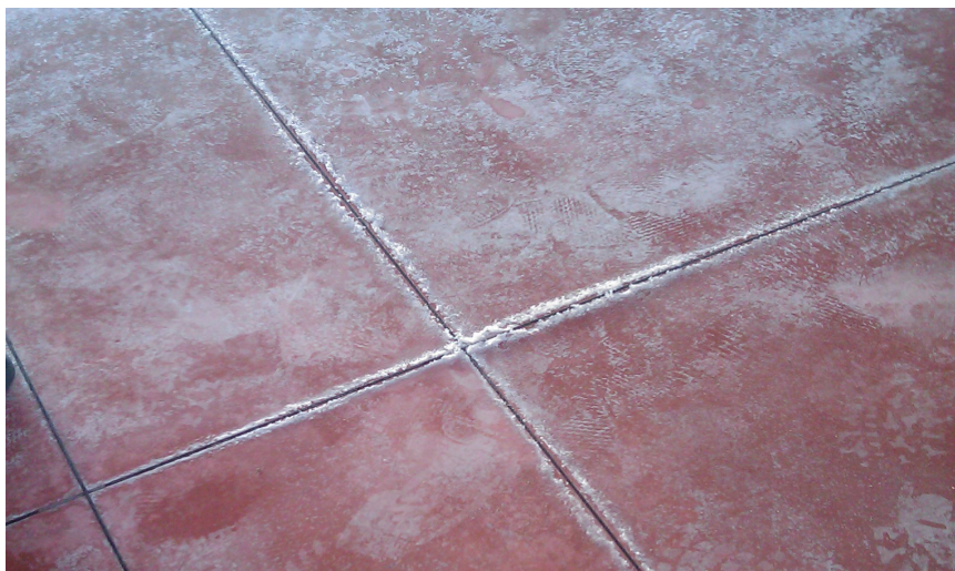
Foto 18. Risalita di idrossido di calcio per capillarità (assenza di barriera al vapore )
