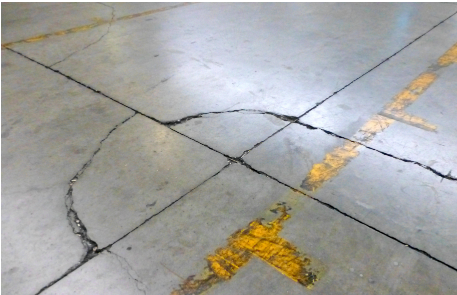
Foto 12. Fratture circolari causate dall'imbarcamento degli angoli dei quadrotti
