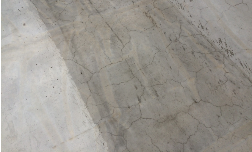
Foto 14. Evidenziazione delle cavillature dopo il passaggio della lavasciuga ( 6 mesi dal getto)
