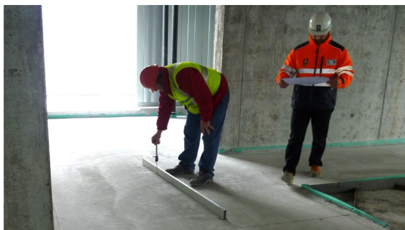
Foto 19. Rilevamento dei valori di planarità
