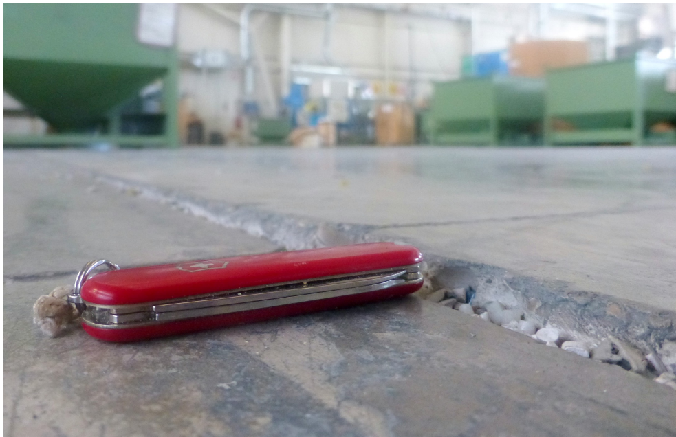
Foto1. Lastra sottile sollevata per "effetto curling" e mancanza barrotti di trasferimento carichi
