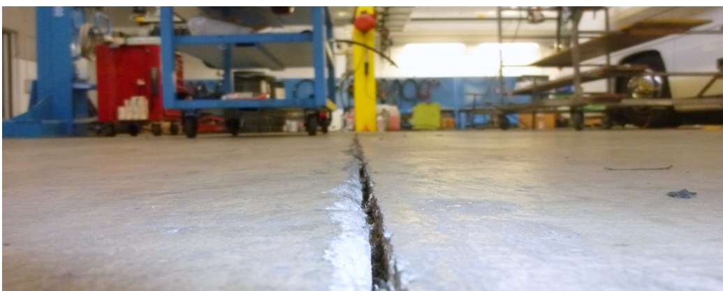
Foto 3. Giunto di costruzione realizzato per accostamento, senza giunto tecnico e i barrotti di trasferimento carichi -Allargamento ed imbricamento
