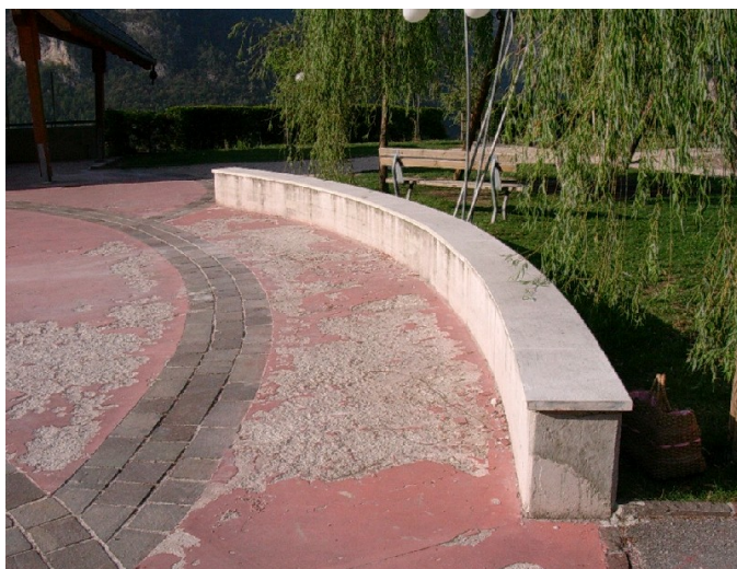
Foto 17. Effetto dei sali disgelanti in area di attesa autobus
