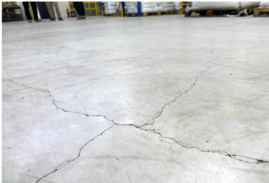
Foto 10. Fessure da ritiro igrometrico per errato dimensionamento dei tagli di contrazione ( 6 m x 6 m con spessore 10 cm)
