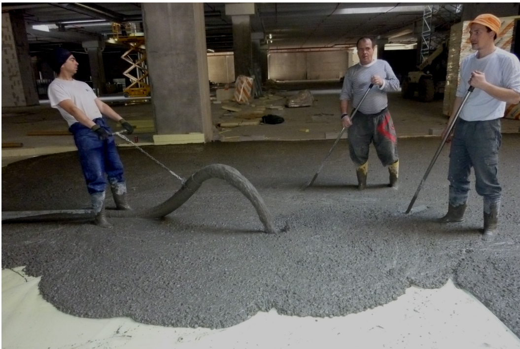
Il lavoro dei pavimentisti facilitato da una reologia “ autolivellante”, coesiva e priva di segregazione. Le fibre XFiber 54 risultano omogeneamente inglobate senza affioramenti anche in fase di staggiatura e frattazzatura.
